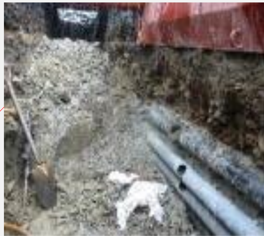
道路の工事（掘削）の様子
